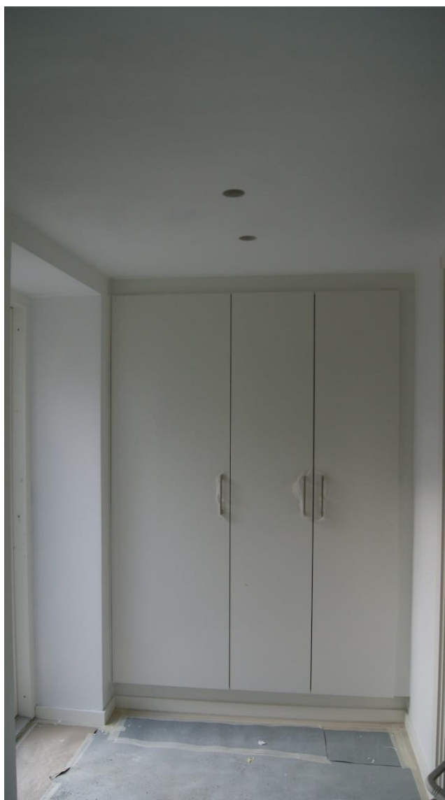
Entré med el-skab samt garderobeskabe
